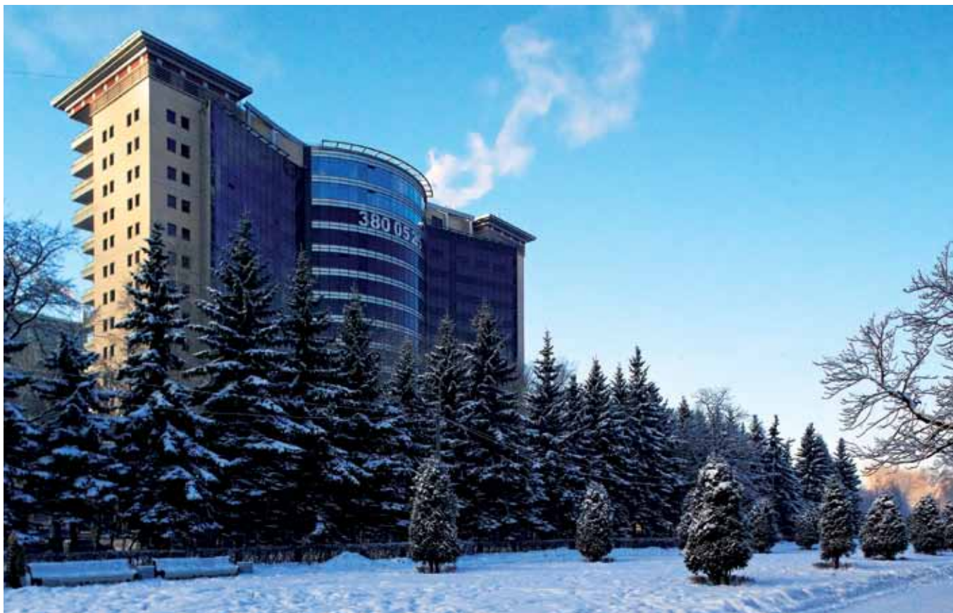
▲ Здание после реконструкции
